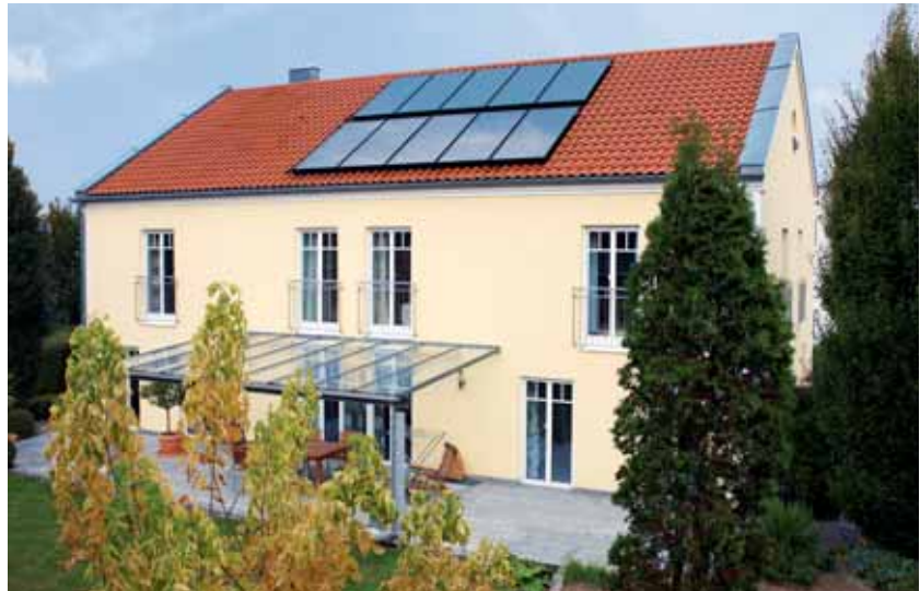
Vitosol 200-FM Zweifamilienhaus Geisenfeld
