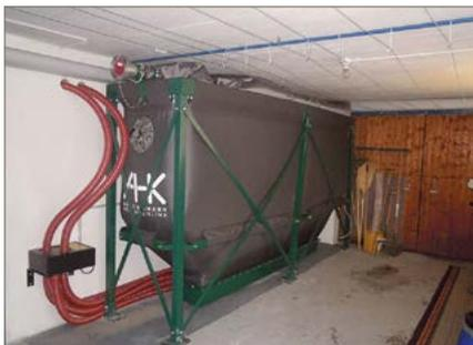
Abb. 10b: Trog silo mit mehreren Saugentnahmepunkten
