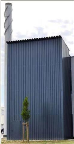
Abb. 34: Beispiel eines eingehausten Pelletsilos zur Außenaufstellung
